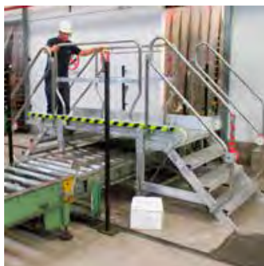
EM1108 Pasarela / Passadiço
