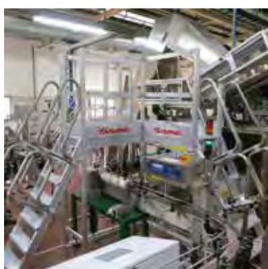
EM1107 Pasarela / Passadiço
