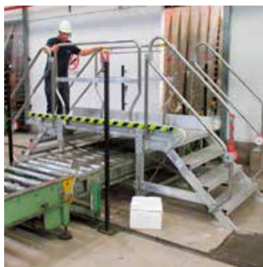
EM1108 Pasarela / Passadiço
